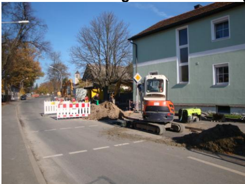
Erneuerung der Wasserleitung (ca. 800 m) aus den 50er Jahren in der Hauptstraße (2010).
