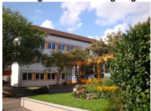
Außensanierung der Grundschule (2009/2010), Schaffung einer kindgerechten Lernatmosphäre durch Ausgestaltung zu einer modernen Bildungseinrichtung mit entsprechendem Betreuungsangebot.
