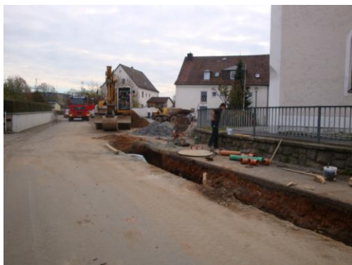
Erneuerung des Abwasserkanals (ca. 350m) aus den 60er Jahren in der Hauptstraße (2010).
